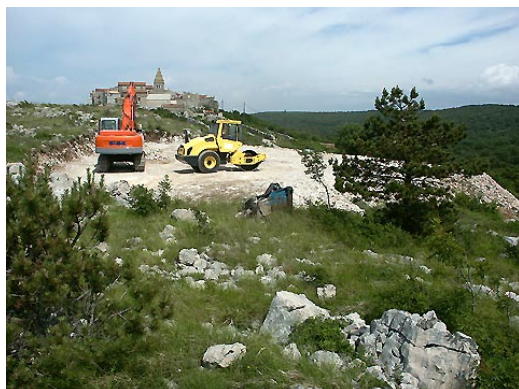
Slika 3: Konstrukcija novog parkirališta
