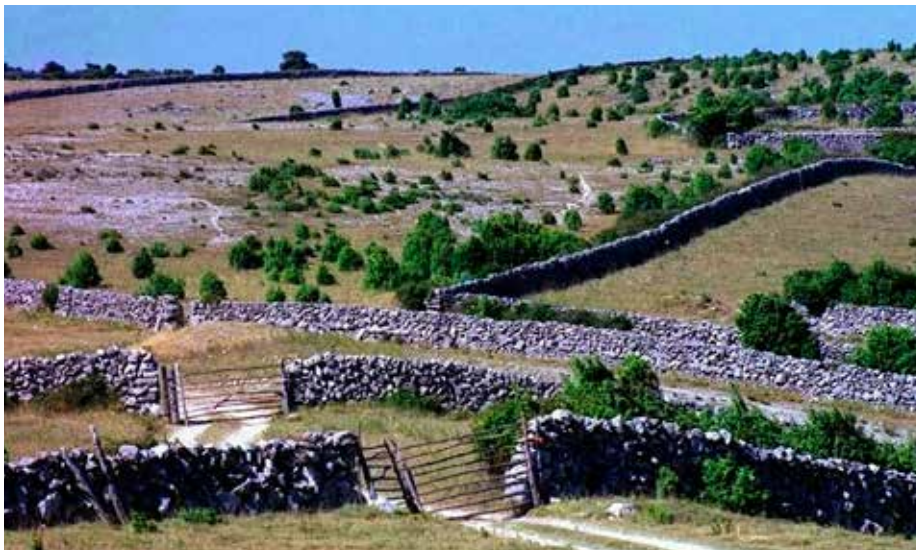
Suhozidne kamnite ograje dajejo poseben pečat tej pokrajini. Stoletja so otočani s pašnikov odnašali kamenje in ga zlagali v ograje, ki še danes stojijo.
